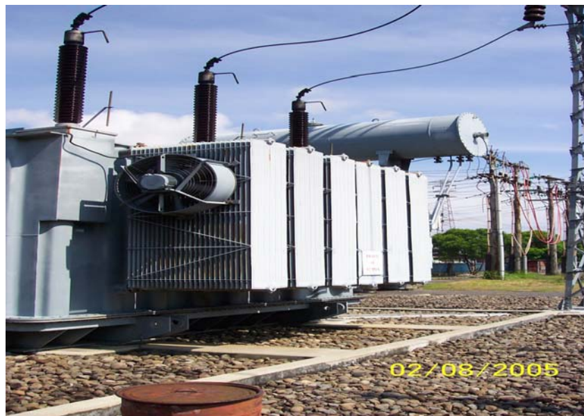
Gambar 3. 11 pendingin trafo type ONAF
